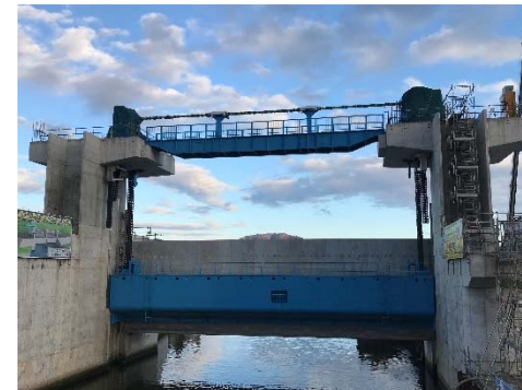
ゲート駆動装置 (大型チェーン式)
