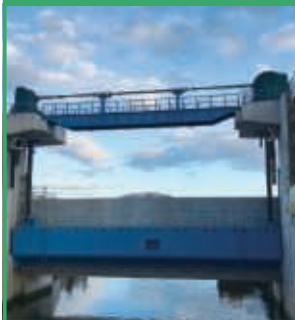
ゲート駆動装置(大型チェーン式)
