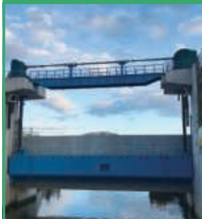
ゲート駆動装置(大型チェーン式)
