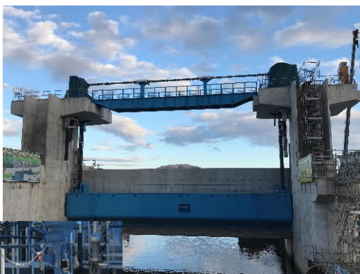
ゲート駆動装置 (大型チェーン式)
