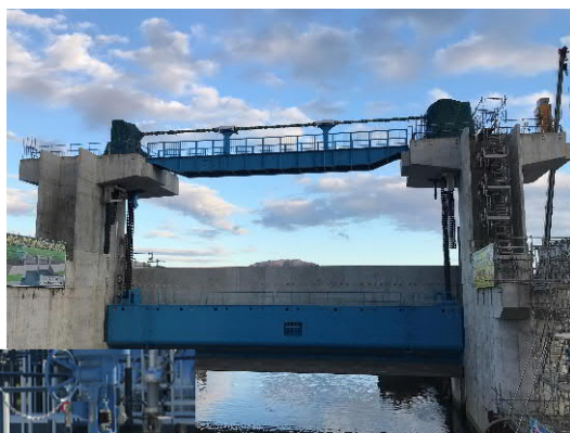
ゲート駆動装置 (大型チェーン式)
