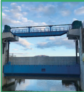
ゲート駆動装置(大型チェーン式)
